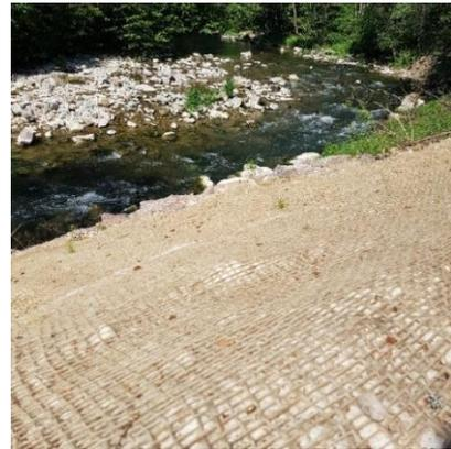
Dieses innovative Produkt besteht aus zwei Schichten. Die unterste Schicht besteht aus hochwertigem Viskosevlies aus Schafwolle mit integriertem Saatgut und Düngemitteln, um eine gleichmäßige Vegetation zu fördern.
